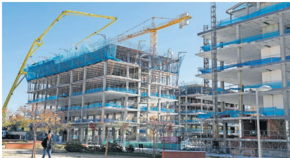
Viviendas en construcción en Villaverde (Madrid). PABLO MONGE
